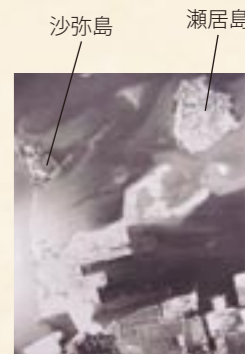
埋め立て工事が進む番の州(昭和42年)
