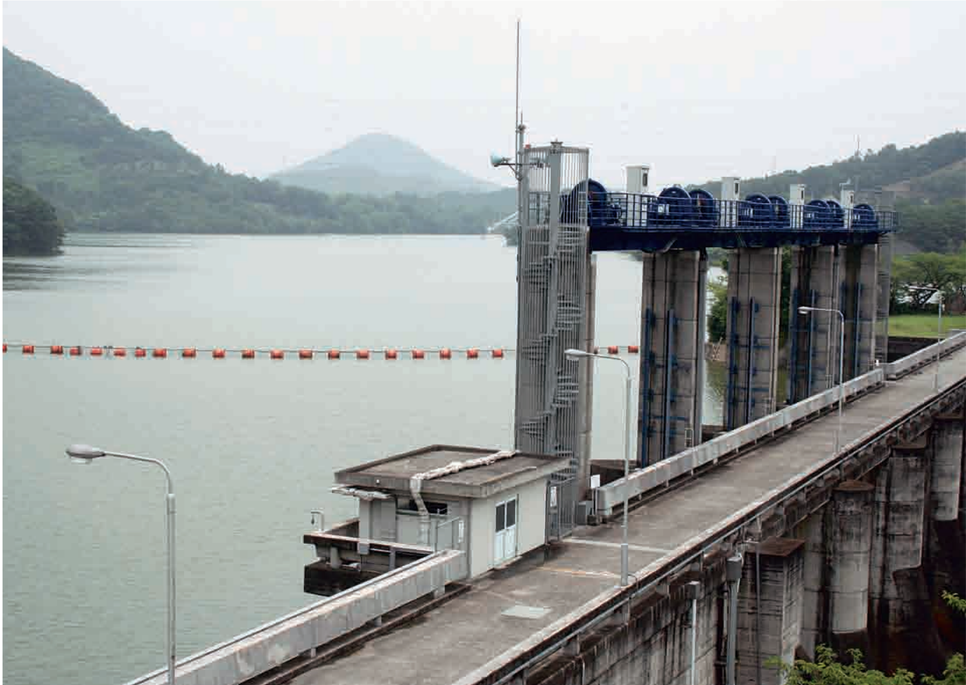
府中ダム(昭和41年完成 堤長400m 堤高27.5m 体積39,250m 3 総貯水量850万t 総事業費21億円)
